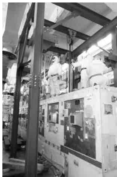
(操作室からの揚重架台)
