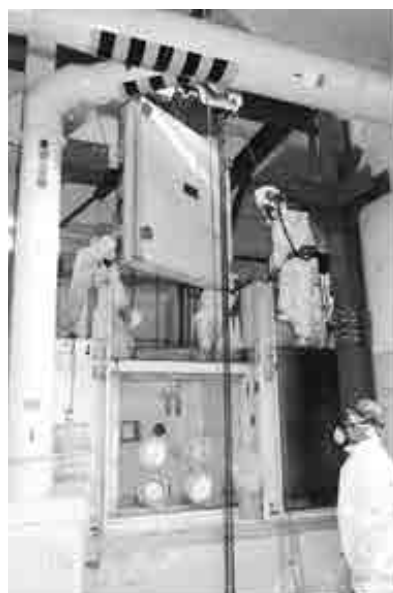
(背面扉引抜き時)
