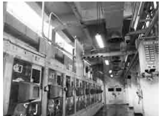
(操作室側からのUMセル)
